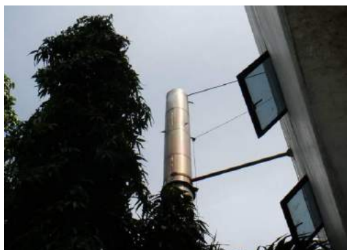
ภาพที่ 1-5 เครื่องดักไอระเหย (Wet Scrubber)
